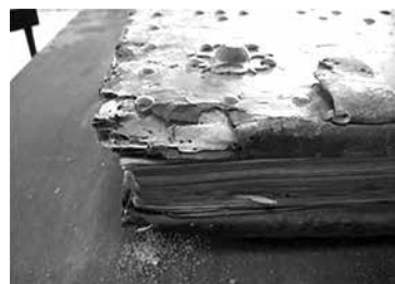
Figura 3: El caso más crítico con este tipo de deterioro. Resultando al mismo tiempo el más crítico por deterioro biológico (no activo) de los ejemplares del Fondo de Raros y Valiosos de la BNCJM.
